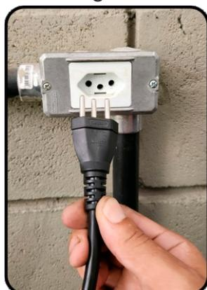
**Figura 11:** Cabo 2P+T para 10A em acordo com a NBR 5410
