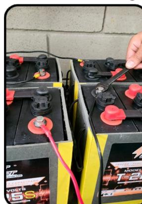
**Figura 4:** Terminal M10 da extremidade do cabo sendo fixado nos parafusos, cabo vermelho no positivo e o cabo preto no negativo do banco de baterias.
